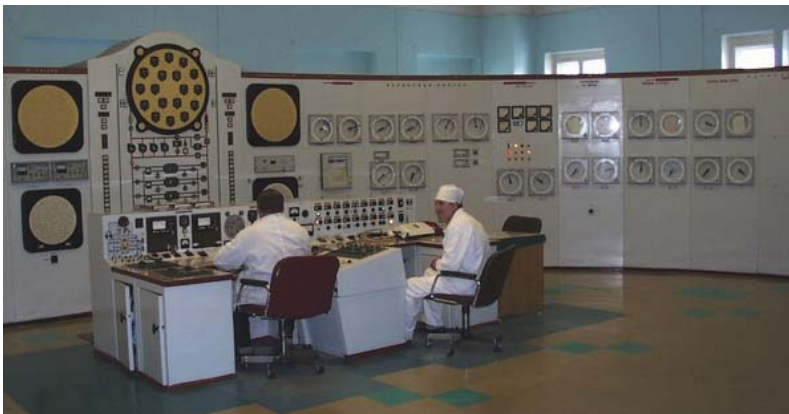
Kontrollraum des ersten Atomkraftwerkes in Obninsk
